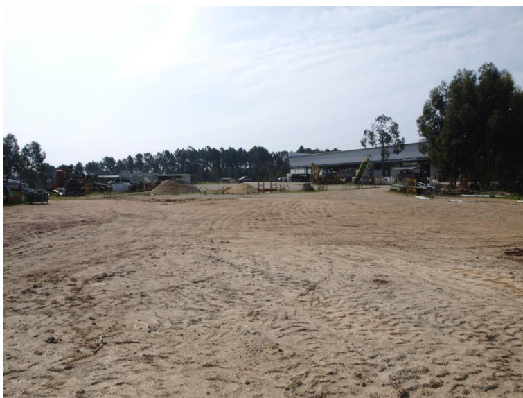
Figura 3 – Plataforma artificial nas traseiras do edifício existente
