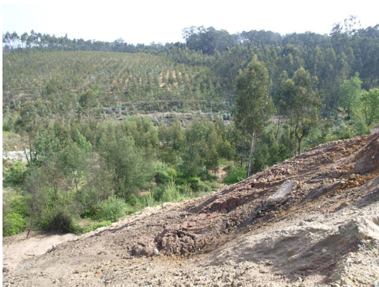
Figura 9 – Talude Norte, vendo-se, abaixo, o eucaliptal junto à ribeira
