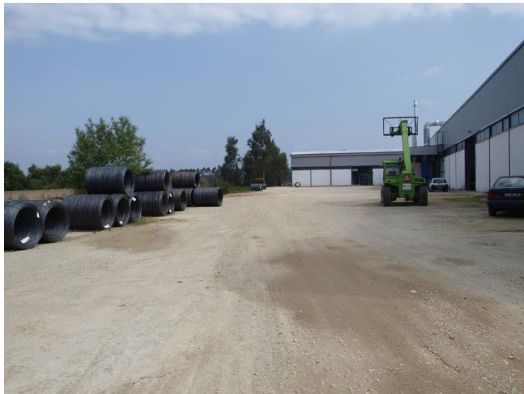
Figura 4 – Piso de terra batida na lateral Oeste do edifício existente
